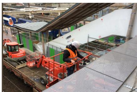
Pose des protections caténaires horizontales de la seconde passerelle
