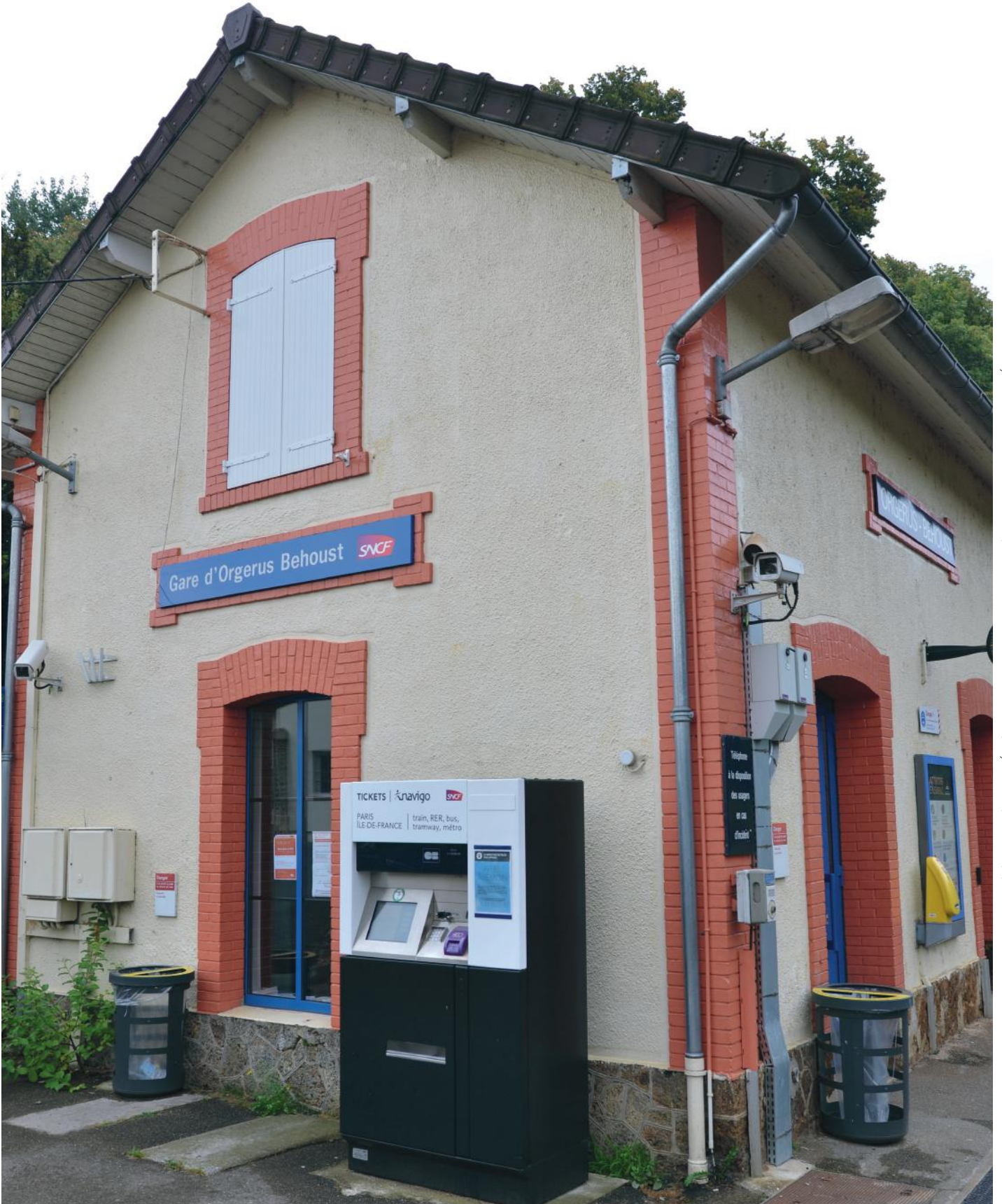
GARE DE ORGERUS-BÉHOUST SUR LA LIGNE N
